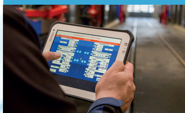
▲ Установка мойки пассажирского поезда /ICE (вверху) Панель управления (внизу)
